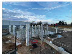
Les travaux ont été commencés
